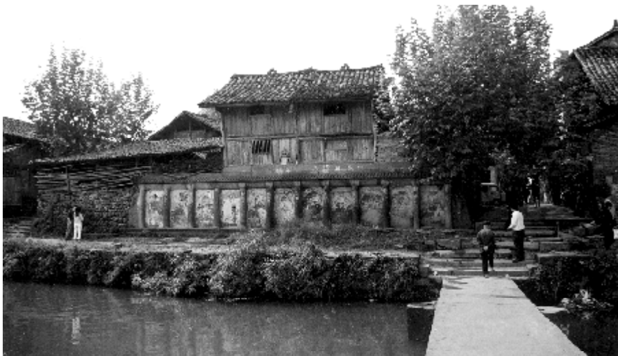
建于清咸丰元年（1851年）的永寿桥，为13孔石平桥，呈南北向横跨夹关河。
